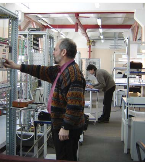
Наладка шкафов управления на испытательном стенде
