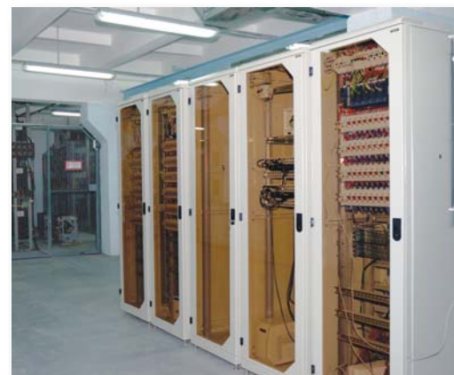
Автоматизированная система контроля и управления системой возбуждения на испытательном стенде
